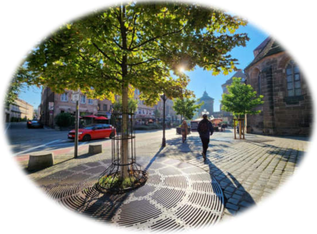
Abbildung 20: Baumrost in Nürnberg, der die Wurzeln vor Begehen und Befahren schützt. Foto: Annette Hartmann 2025
