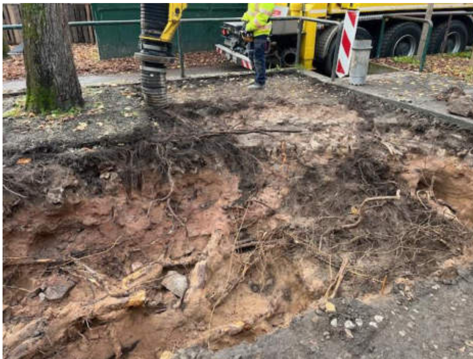
Abbildung 38: Großer Saugbagger im Einsatz auf Biergartengelände in Erlangen. Foto: Marco Müller 2018
