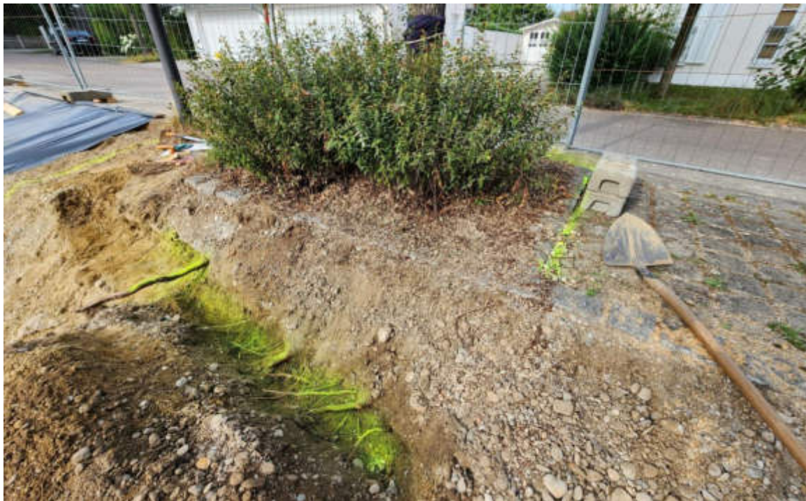
Abbildung 37 Wurzelsondierung per Handschachtung: Schaufeleinsatz. Foto: Annette Hartmann, 2025.
