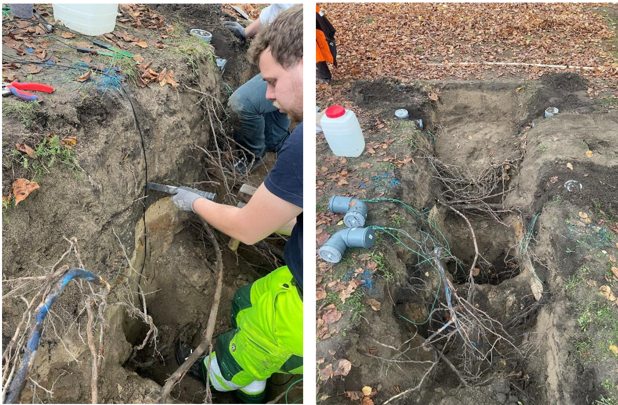
Abb. 5 & 6: Installation von volumetrischen Bodenfeuchtesensoren in einem Profil an einem Altbaum in einer Parkanlage - Fotos Landeshauptstadt Hannover
