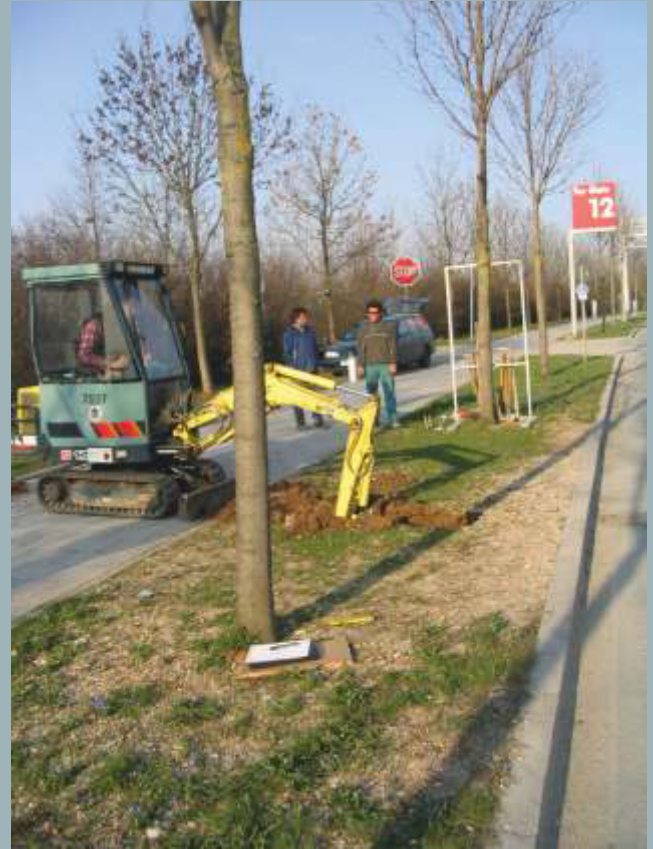
Abb. 11a: Aufgrabung zur Bewertung der Wurzelentwicklung in Baumgräben (Foto: Leander Wilhelm, München)
