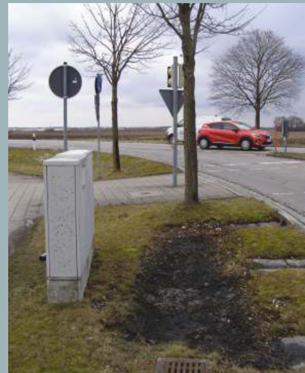
Abb. 2 (rechts): Ablagerungen aus direkter Einleitung von hochbelastetem Niederschlagswasser inkl. Auftausalzen von einer mehrspurigen Straße in Mulden und den Wurzelbereich von Bäumen. (Foto: Leander Wilhelm, Eching)
