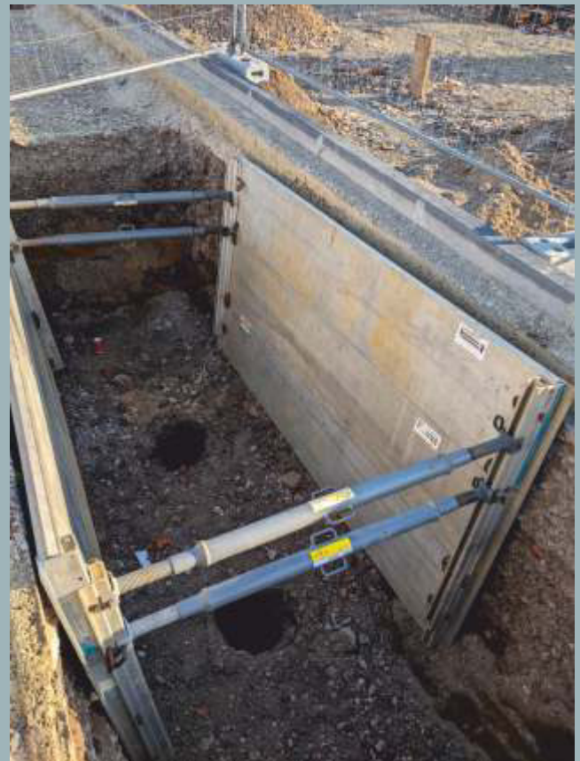
Abb. 7: Tiefenbohrungen zur Wurzelraumerweiterung nach FLL (Foto: Daniel Gerhardt, Köln)
