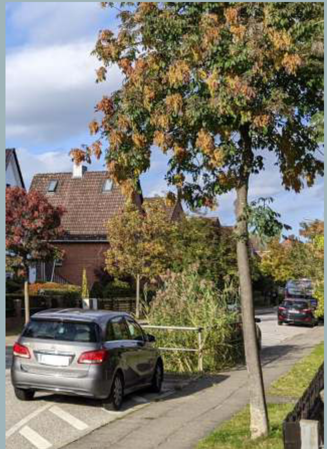
Abb. 13: Räumlich von den Baumstandorten getrennte Versickerungsanlage/Tiefbeet-Rigole zur Starkregenvorsorge. (Foto: Torsten Melzer, Hamburg)
