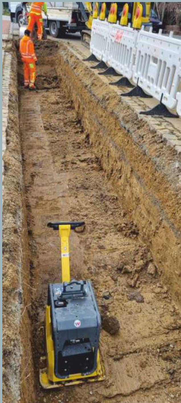
Abb. 5+6: „Baum-Rigolen“; Einbau einer 40 cm Wasserauffangwanne aus anstehendem Lehm per Rüttelplatte (Pilotanlage aus dem Forschungsprojekt Pfaffenhofen „Multifunktionale Versickerungsmulden im Siedlungsraum“ oben, Foto: Johannes Prügl) und Einbau einer Sperrschicht als Bentonit-Matte (Foto: Torsten Melzer, HH-Bergedorf, links)
